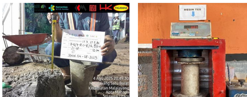
Gambar 7. Pengujian Slump dan Uji Tekan Beton
