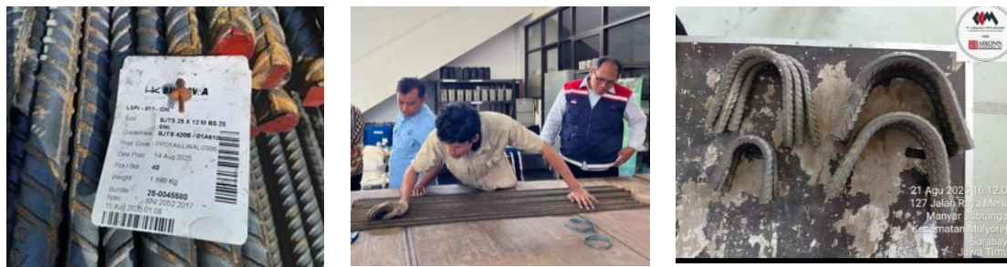
Gambar 8. Pengujian dan Pengawasan Mutu Tulangan Baja
