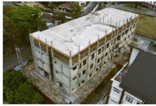
Gambar 9. Pengecoran Atap Dak
