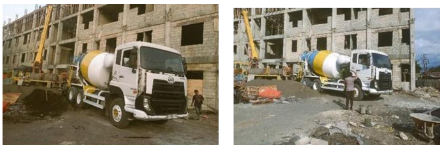
Gambar 8. Penuangan Beton untuk Pekerjaan Atap Dak
