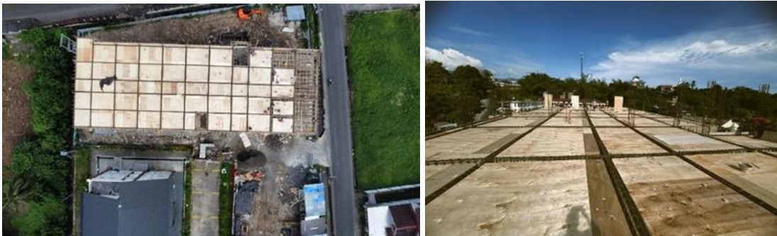
Gambar 5. Bekisting Atap Dak
