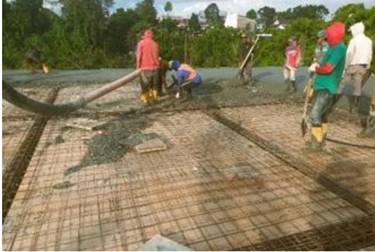
Gambar 9. Pengecoran Atap Dak
