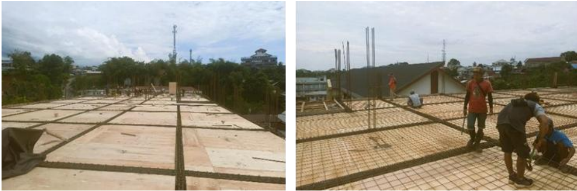
Gambar 6. Penulangan Atap Dak
