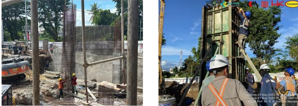
Gambar 8. Pemasangan Tulangan & Bekisting Kolom
