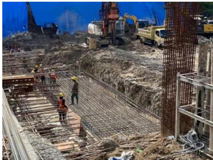
Gambar 5. Pembesian Pile Cap
