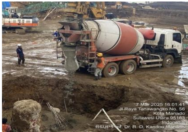
Gambar 4. Pengecoran Lantai Kerja
