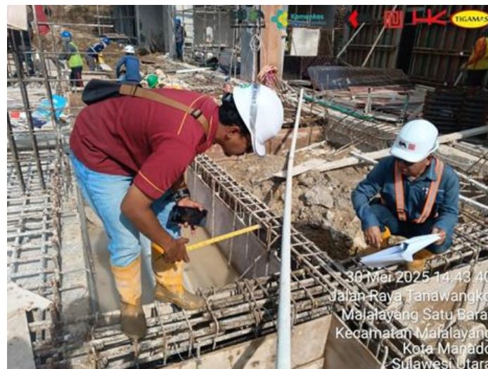
Gambar 7. Pemasangan Tulangan Tie Beam
