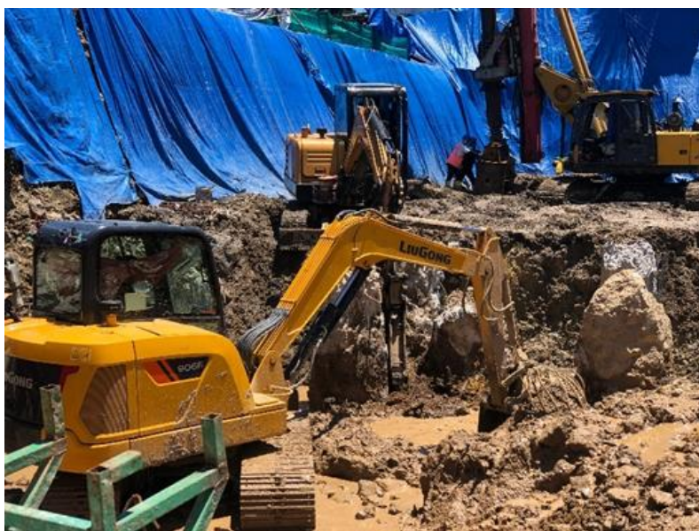
Gambar 3. Pekerjaan Galian Tanah
