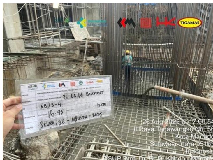
Gambar 6. Pengecoran Pile Cap
