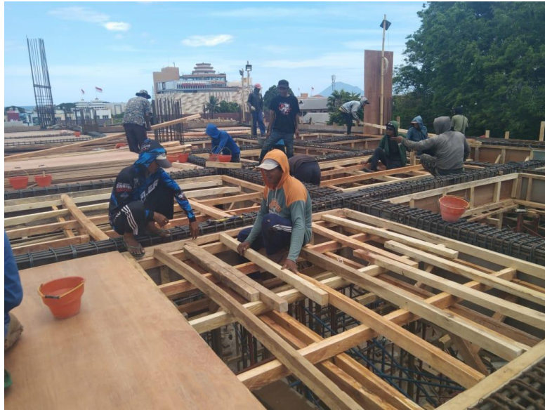
Gambar 8. Pemasangan Bekisting Pelat Lantai
