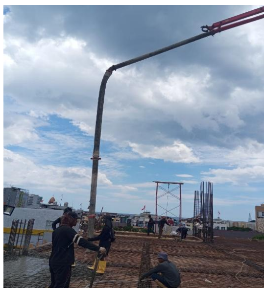
Gambar 7. Pekerjaan Pengecoran Balok
