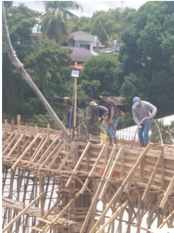
Gambar 4. Pekerjaan Pengecoran dan Pematatan dengan Vibrator
