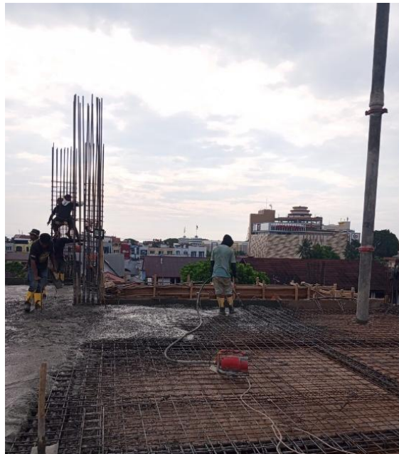
Gambar 11. Pekerjaan Pengecoran Pelat Lantai
