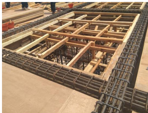
Gambar 6. Pekerjaan Pembesian
