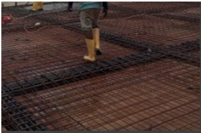
Gambar 9. Pemasangan Tulangan Pelat Lantai
