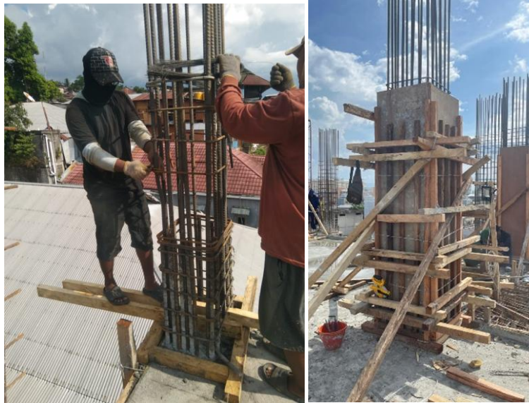
Gambar 3. Pekerjaan Pembesian (kiri) dan Pemasangan Bekisting (kanan)
