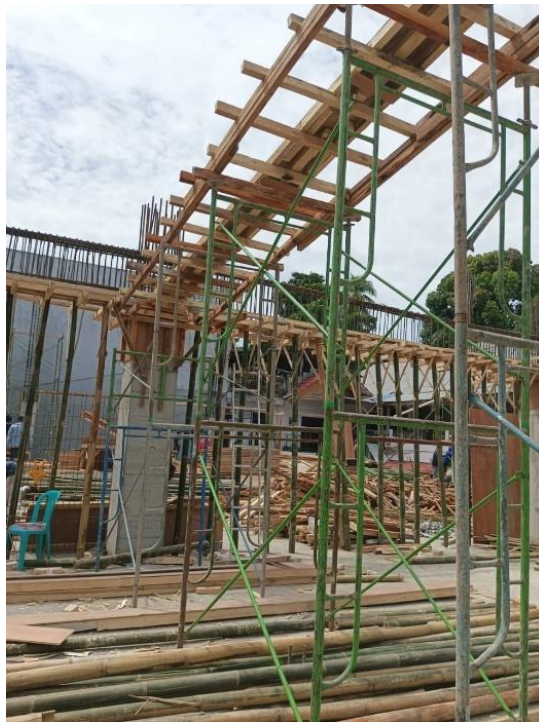
Gambar 5. Pemasangan Bekisting dan Perancah
