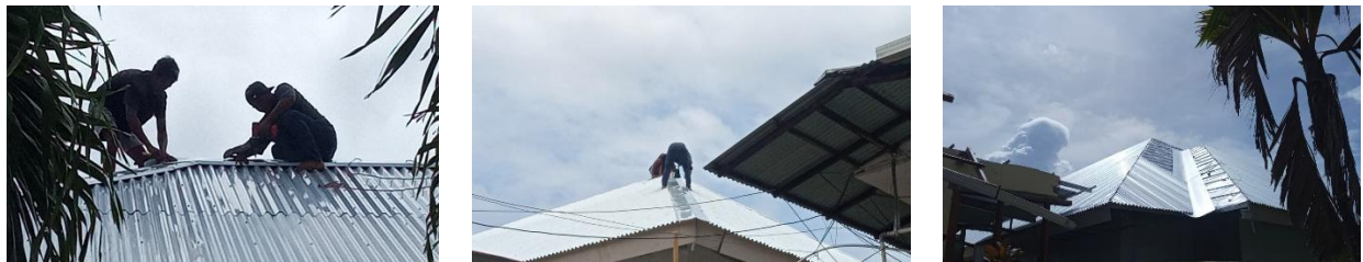
Gambar 10. Pemasangan Nok dan Jurai Atap
