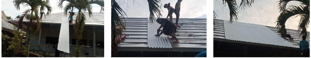
Gambar 9. Pemasangan Penutup Atap
