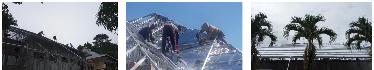
Gambar 7. Pemasangan Reng
