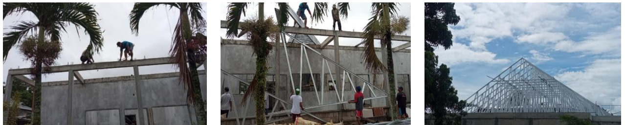
Gambar 5. Pemasangan Kuda-Kuda Atap Baja Ringan
