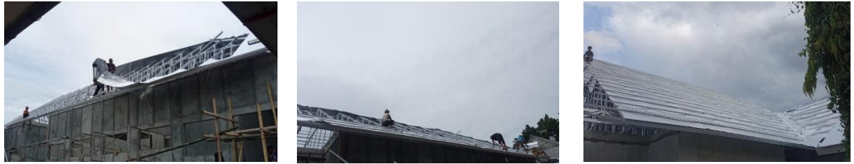
Gambar 6. Pemasangan Aluminium Foil
