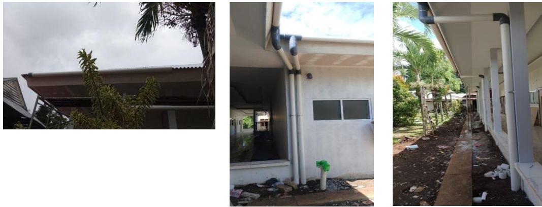
Gambar 11. Pemasangan Lisplang
