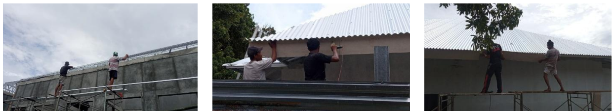
Gambar 8. Pemasangan Lisplang
