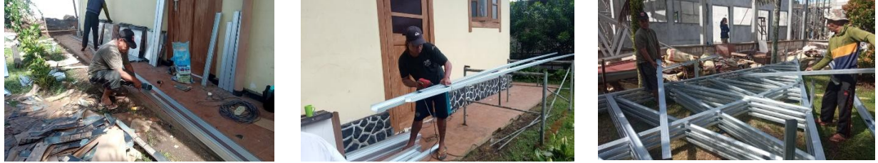
Gambar 4. Perakitan Kuda-Kuda Atap Baja Ringan
