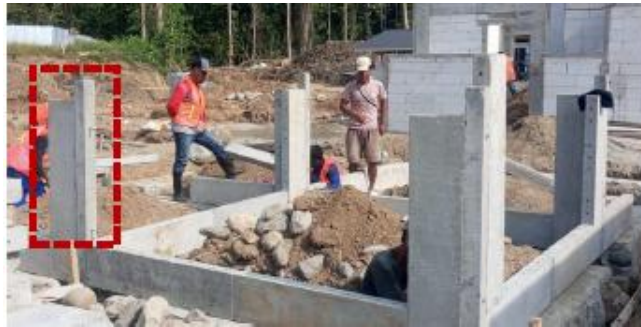
Gambar 7. Pemasangan Panel Sloof
