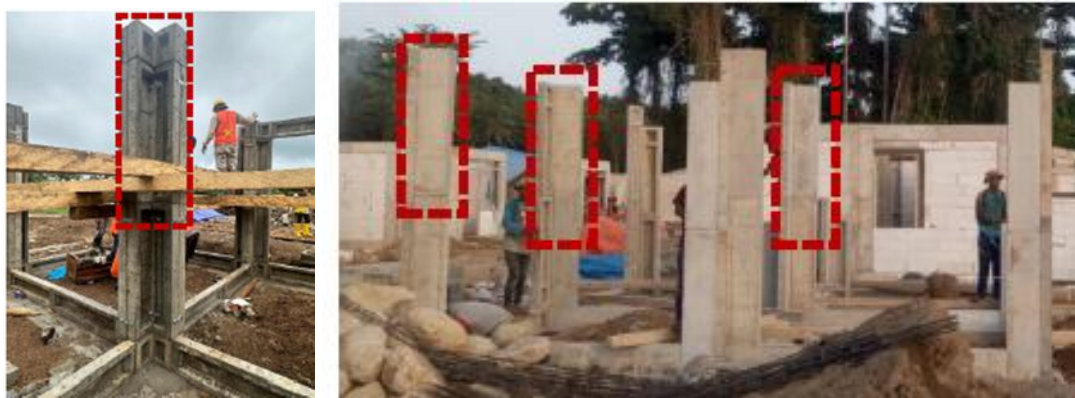
Gambar 8. Pemasangan Sambungan antar Panel Kolom Atas di Titik Inti Rumah (kiri) dan Pemasangan Sambungan antar Panel Kolom pada Rumah (kanan)
