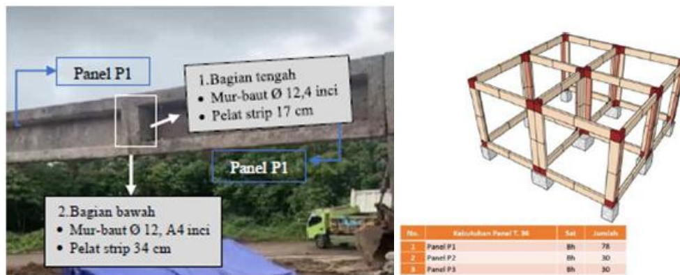
Gambar 10. Pemasangan Panel Penyambung dan Panel Balok Atas (Ring Balok) (kiri) dan Struktur RISHA (kanan)
