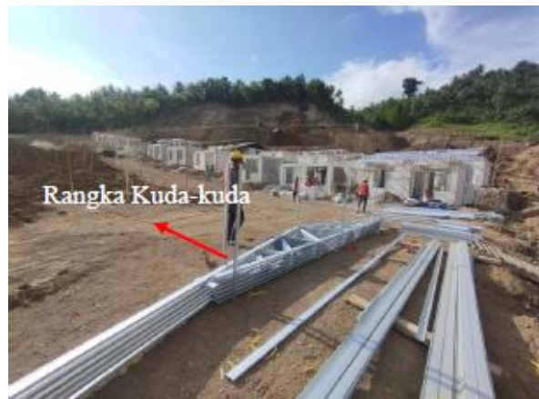
Gambar 11. Pemasangan Pembuatan Rangka Kuda-kuda Atap
