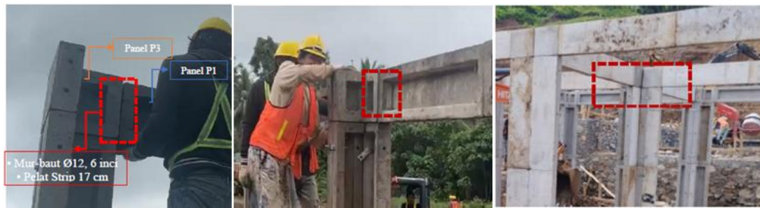
Gambar 9. Pemasangan Panel Ikat
