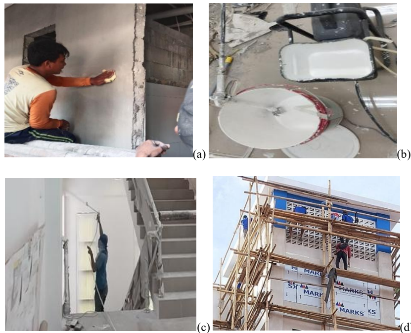
Gambar 7. (a) Proses Pengamplasan Permukaan Dinding; (b) Campuran Cat Siap Digunakan; (c) Proses pengecatan Interior Dengan Metode Semprot; (d) Proses Pengecatan Eksterior Metode Manual (Sumber: Hasil Observasi, 2025)
