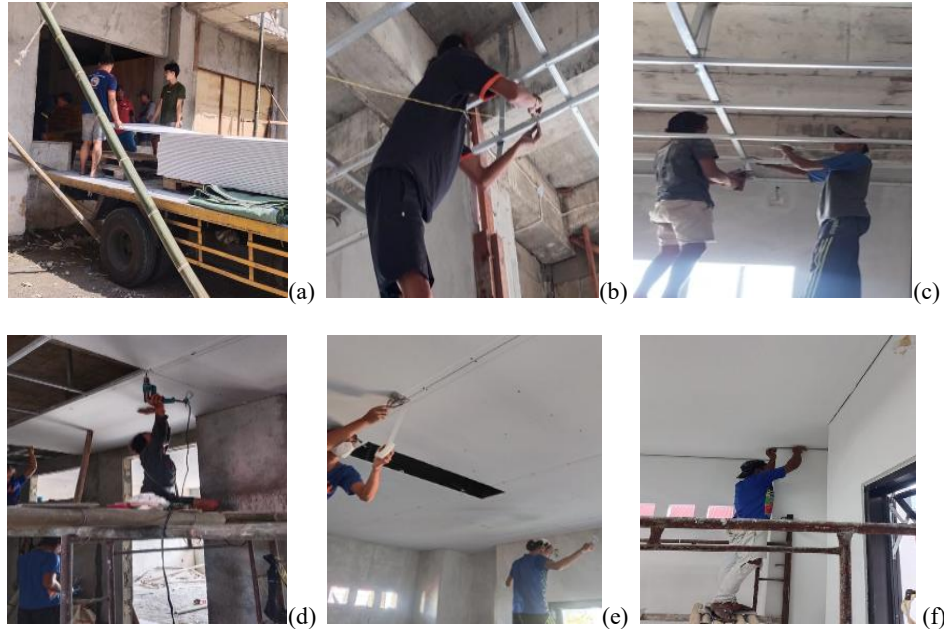
Gambar 5. (a) Paersiapan Bahan; (b) Penentuan Elevasi Menggunakan Waterpass Dan Benang Pedoman; (c) Proses Pemasangan Rangka Prafon; (d) Pemasangan Papan Gypsun; (e) Proses Pemasangan Kompounnd dan Dempul; (f) Pemasangan Lis Plafon (Sumber: Hasil Observasi 2025)
