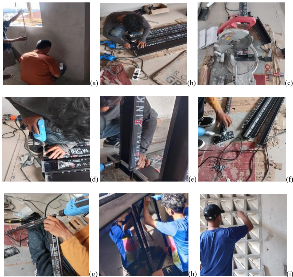
Gambar 6. (a) Pemeriksaan Dan Pengukuran Bukaan; (b) Persiapan Kusen; (c) Proses Pemotongan Kusen; (d) Pemasangan Pengaku Sudut Kusen; (e) Proses Pemasangan Sekrup untuk Mengikat Ujung Kusen; (f) Pemasangan Sekrup pada Ujung Rangka Bingkai Jendela; (g) Proses Perakitan Frame Jendela; (h) Proses Pemasangan Handle pada Bingkai Jendela; (i) Pekerjaan Ventilasi (Sumber: Hasil Observasi, 2025)
