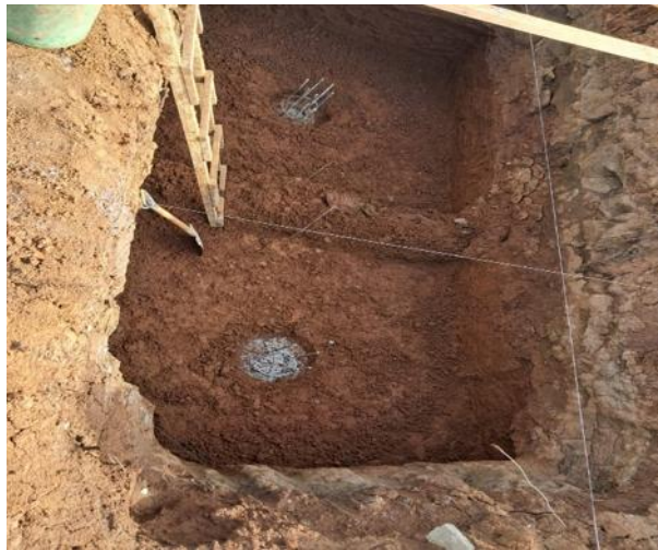
Gambar 8. Pondasi Strauss setelah Pengecoran
