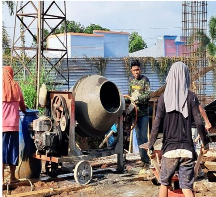
Gambar 6. Pembuatan Beton Side Mix Campuran 1:2:3 (Mutu K-225)
