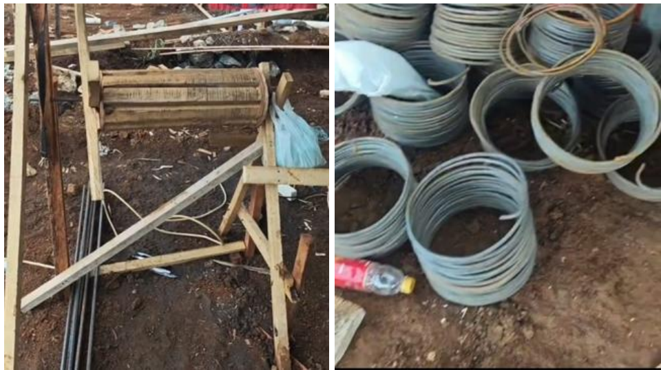
Gambar 4. Alat Pembuatan Besi Spiral dan Tulangan Spiral Ø8-150
