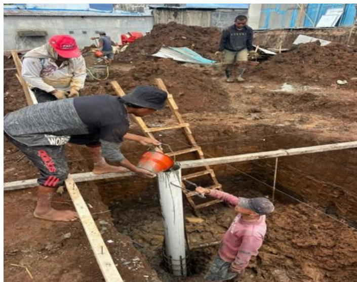
Gambar 7. Penuangan Beton Side Mix melalui Pipa Paralon 10"
