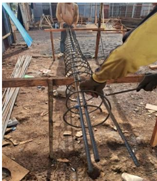
Gambar 5. Pengikatan Tulangan Utama dan Sengkang/Spiral menggunakan Bendrat
