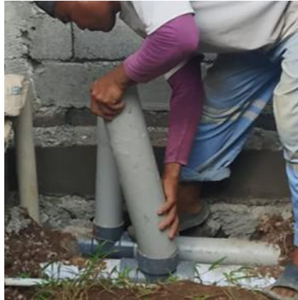
Gambar 9. Pekerjaan Pemasangan Pipa PVC (Sumber: Dokumentasi Lapangan, 2026)
