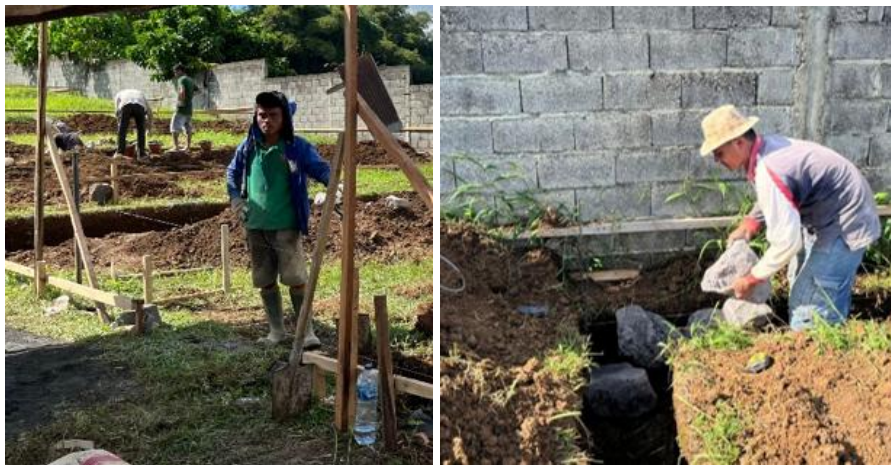
Gambar 4. Pekerjaan Galian Pondasi dan Pemasangan Batu Kali Pondasi (Sumber: Dokumentasi Lapangan 2026)
