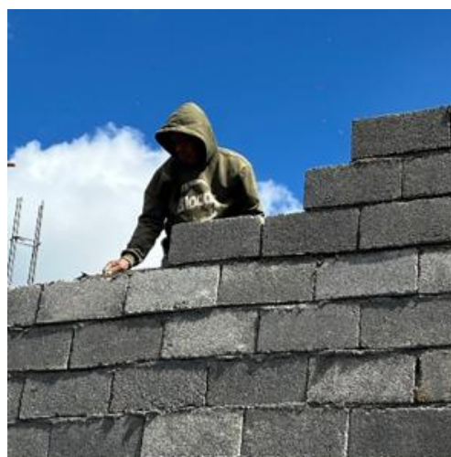
Gambar 6. Pekerjaan Pemasangan Dinding (Sumber: Dokumentasi Lapangan 2026)
