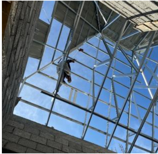
Gambar 7. Pekerjaan Atap (Sumber: Dokumentasi Lapangan, 2026)
