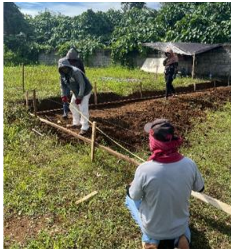
Gambar 3. Pekerjaan Pengukuran dan Pemasangan Patok dan Papan Bantu (Bowplank) (Sumber: Dokumentasi Lapangan 2026)
