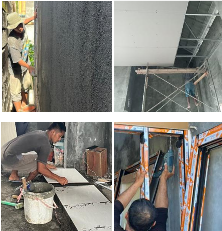
Gambar 8. Pekerjaan Plesteran, Pemasangan Plafon, Pemasangan Keramik dan Pemasangan Kusen (Sumber: Dokumentasi Lapangan, 2026)
