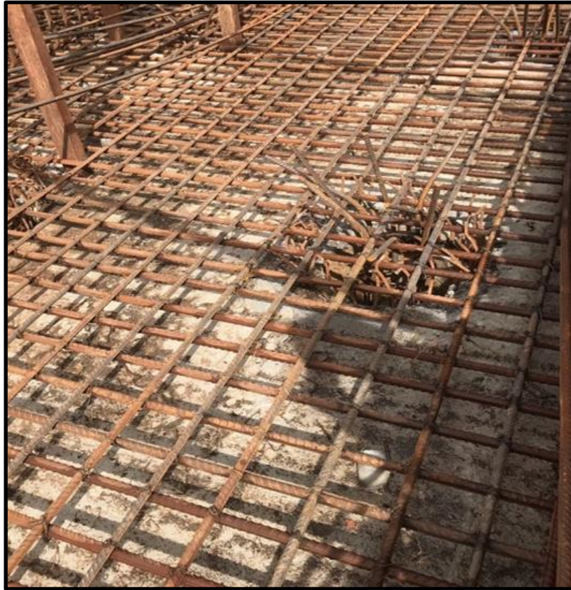
Gambar 11. Penulangan Pile Cap Sumber: Dokumentasi Pribadi
