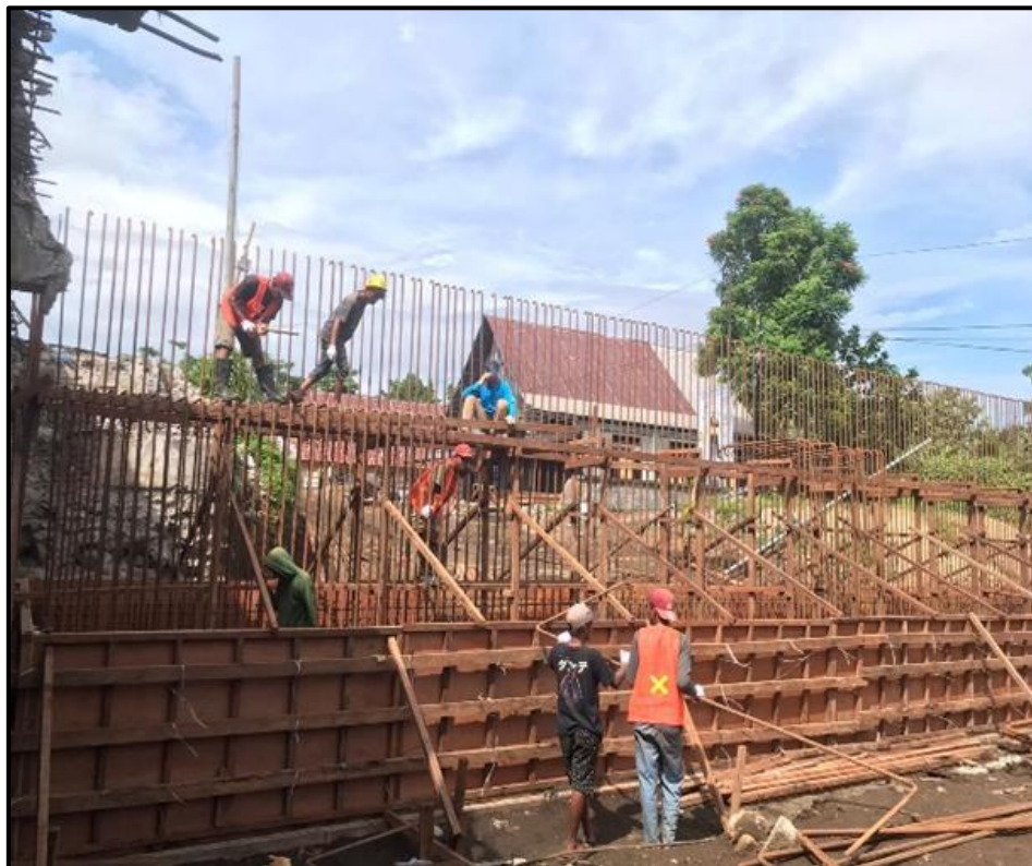
Gambar 12. Penulangan Abutment Sumber: Dokumentasi Pribadi
