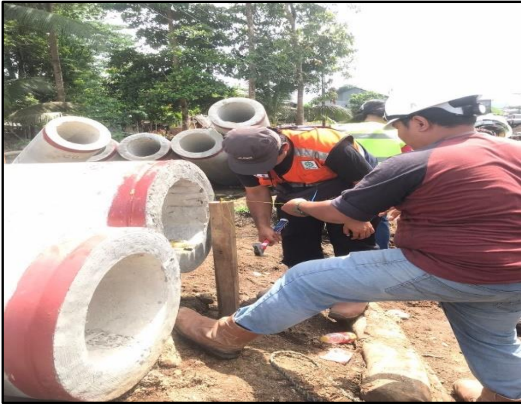
Gambar 5. Penentuan Titik Yang Akan Pancang Sumber: Dokumentasi Pribadi
