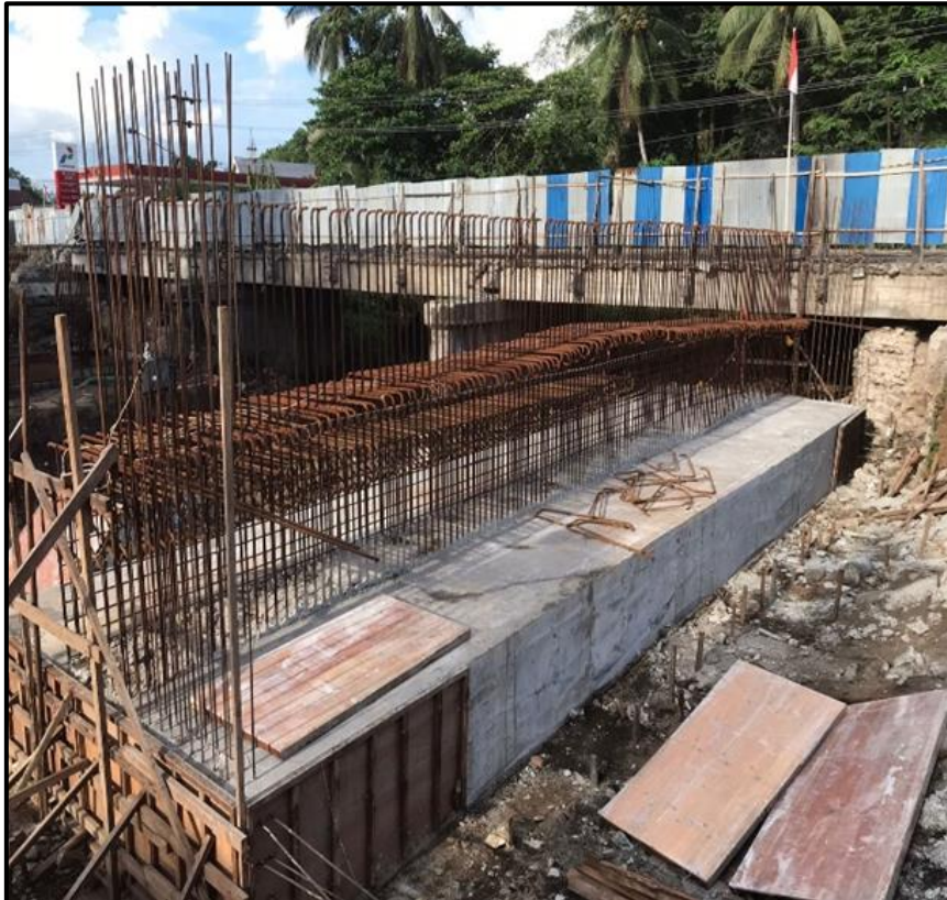
Gambar 14. Pembongkaran Bekisting Pile Cap Sumber: Dokumentasi Pribadi
