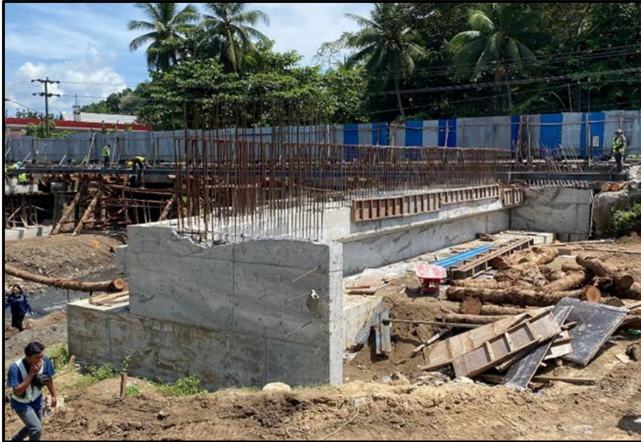
Gambar 17. Pembongkaran Bekisting Abutment Sumber: Dokumentasi Pribadi
