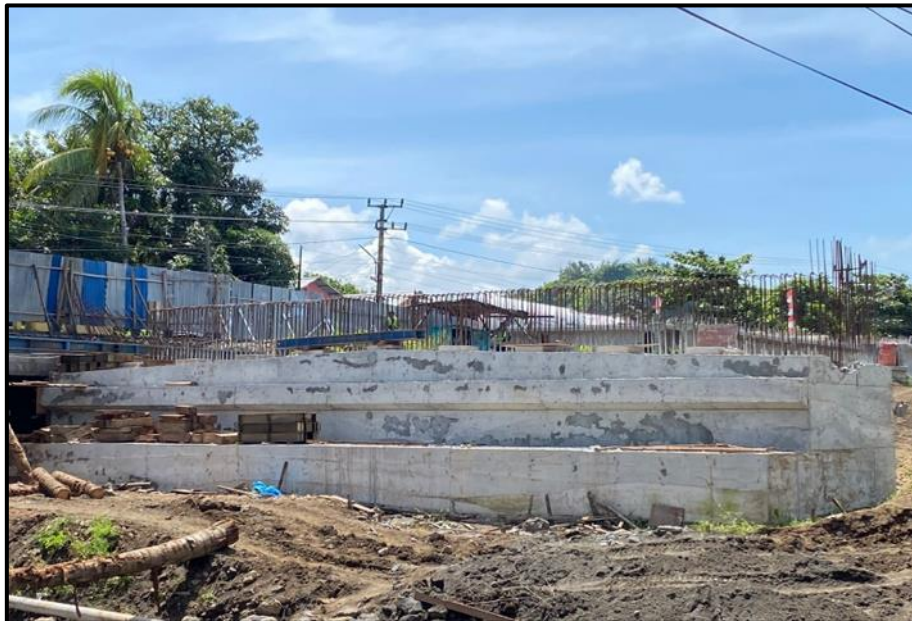
Gambar 18. Pekerjaan Curing Dinding Abutment Sumber: Dokumentasi Pribadi
