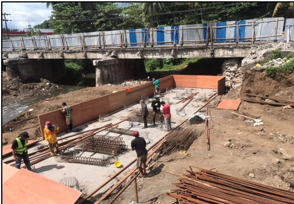
Gambar 10. Pemasangan Bekisting Pile Cap Sumber: Dokumentasi Pribadi
