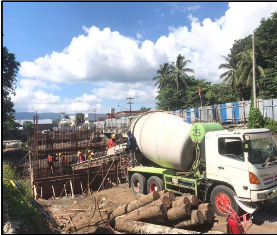
Gambar 13. Pengecoran Pile cap Sumber: Dokumentasi Pribadi
