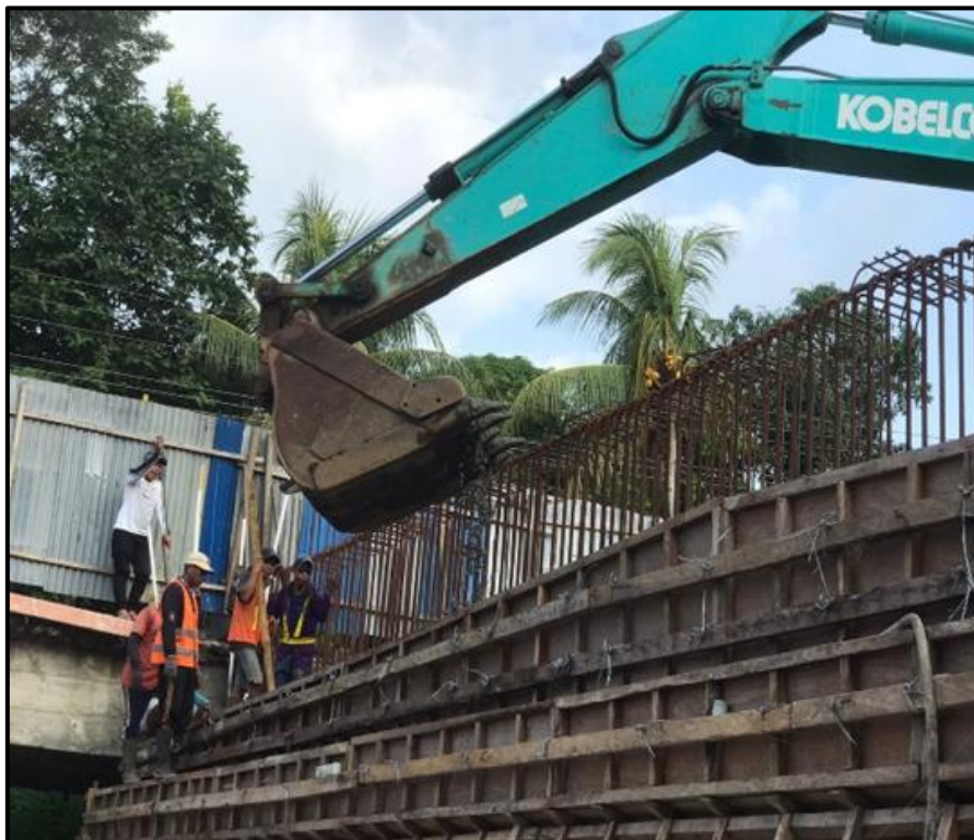
Gambar 16. Pengecoran Abutment Sumber: Dokumentasi Pribadi
