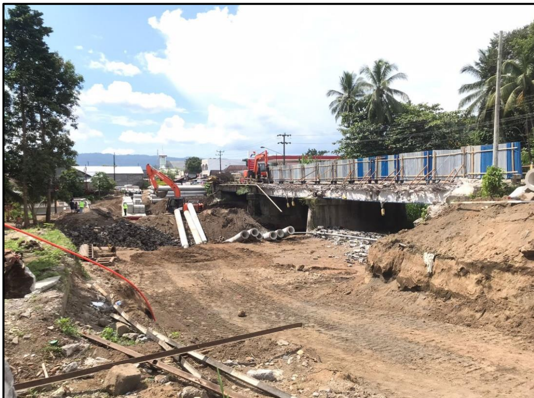
Gambar 4. Pembersihan Lahan Untuk Pemanxangan Tiang Pancang
