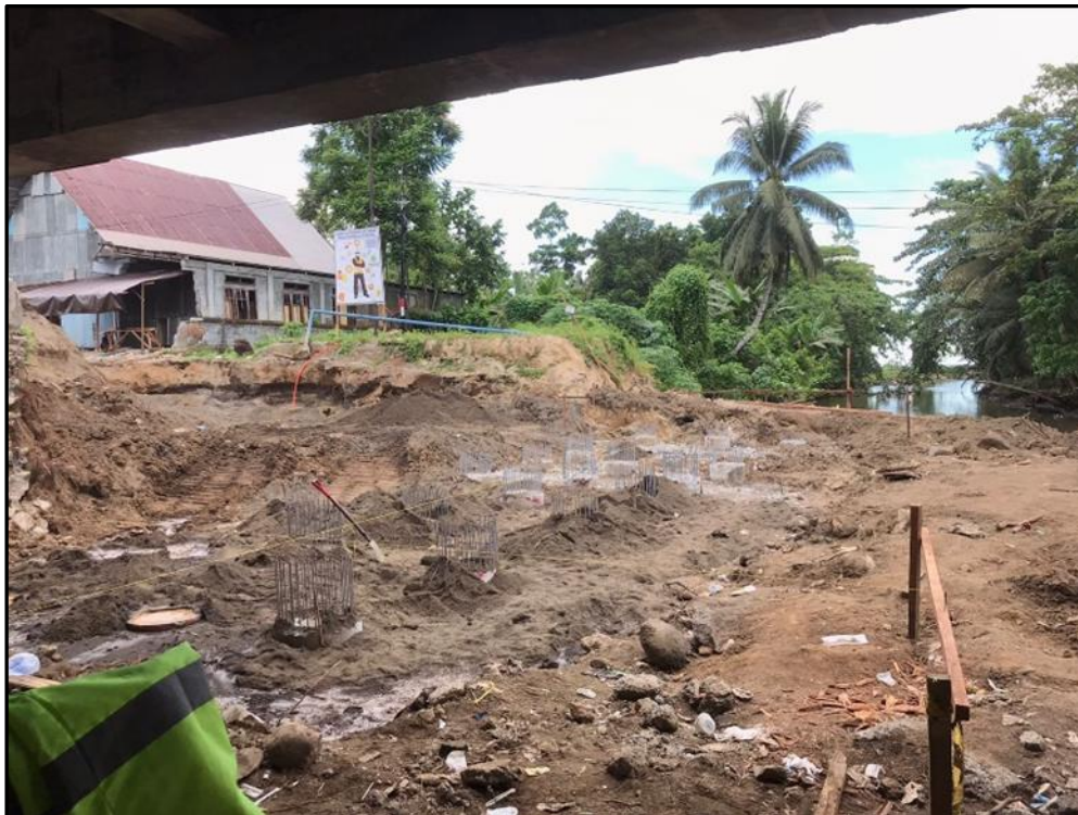
Gambar 8. Pekerjaan Lapis Pasir Dasar Sumber: Dokumentasi Pribadi
