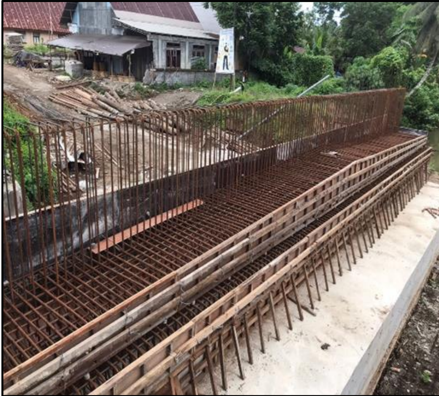
Gambar 15. Pemasangan Bekisting Badan Abutment Sumber: Dokumentasi Pribadi
