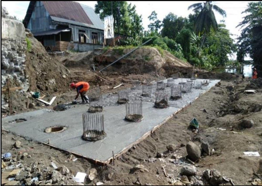
Gambar 9. Pekerjaan Lantai Kerja Sumber: Dokumentasi Pribadi
