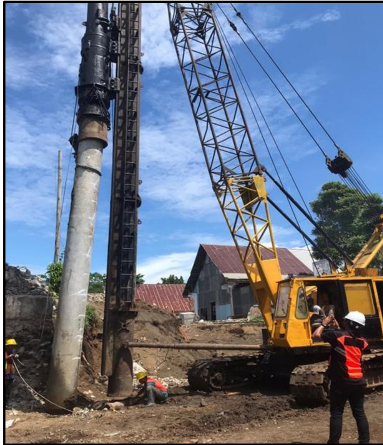
Gambar 7. Pelaksanaan Pekerjaan Pemancangan Sumber: Dokumentasi Pribadi
