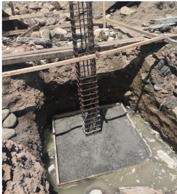
**Gambar 3.** Pengecoran Pondasi Telapak
