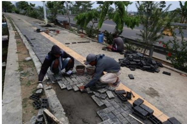
**Gambar 4.** Penerapan Paving Blok Plastik pada Trotoar Jalan Bung Karno
