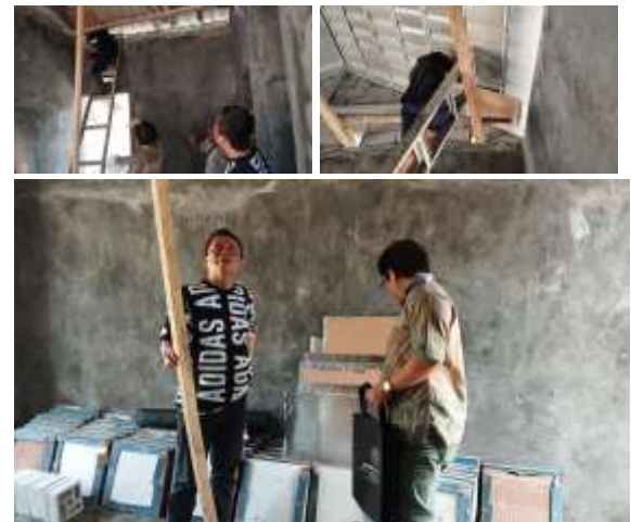
Gbr. 10. Instalasi panel insulasi radiatif dan ventilasi atap pada rumah contoh.
