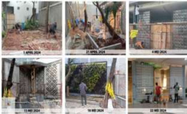
Gambar 7. Proses Pembangunan Taman Doa
