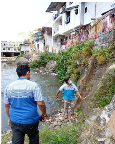
Gambar 1. Pengukuran Ketinggian untuk Tiang Alat Teknologi
