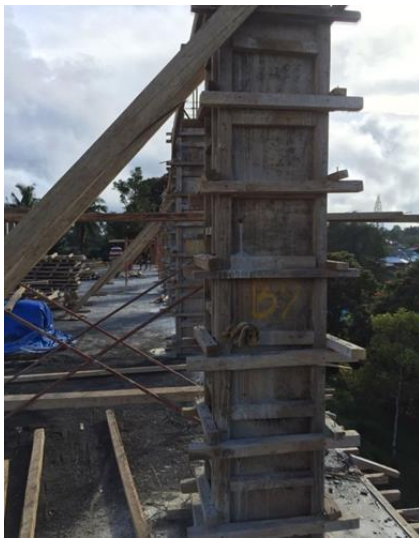
Gambar 3. Bekisting Kolom
