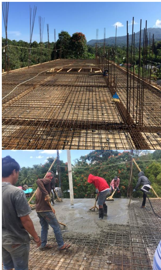
Gambar 6. Pembesian Pelat Lantai dan Balok serta Pengecoran
