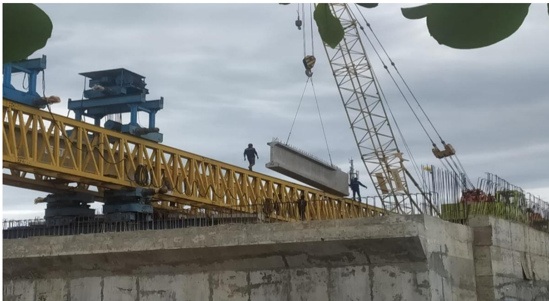
Gambar 2. Proses Launching PCI Girder Sumber: Dokumentasi Pribadi
