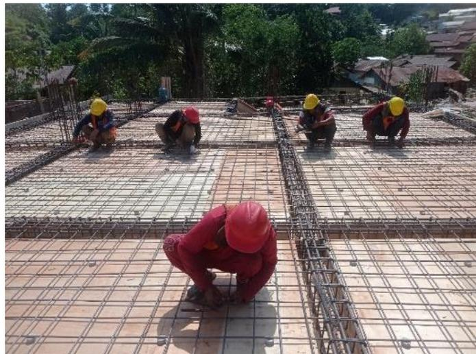
**Gambar 6.** Proses Pemasangan Tulangan Lapis Bawah
